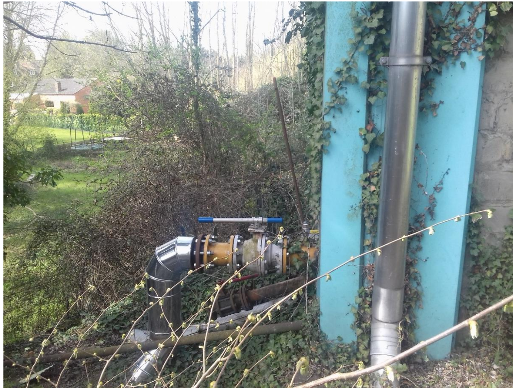
Figure 5 : Vue du secteur A - Arrivée de la canalisation
