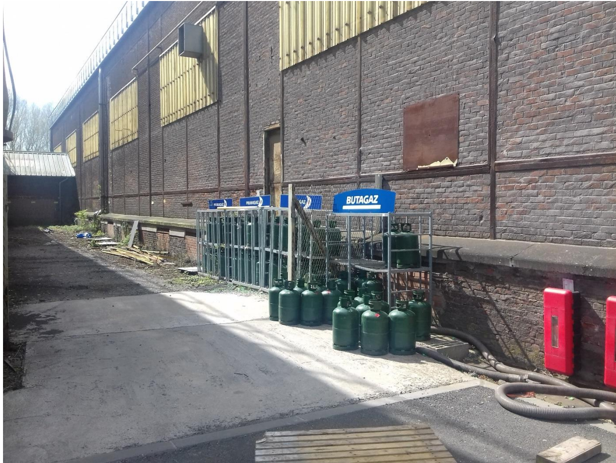
Figure 10 : Vue du secteur F - Stockage des bouteilles de propane
