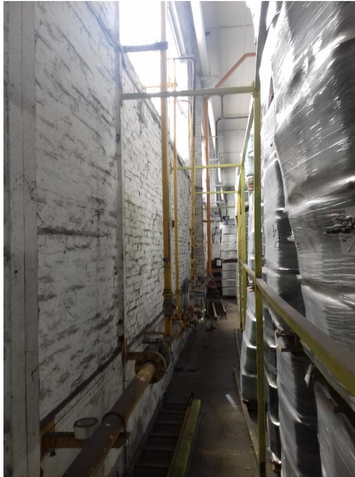
Figure 8 : Vue du secteur D - Zone de stockage
